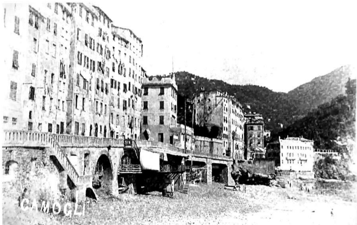
Dopo i lavori di Via Garibaldi
