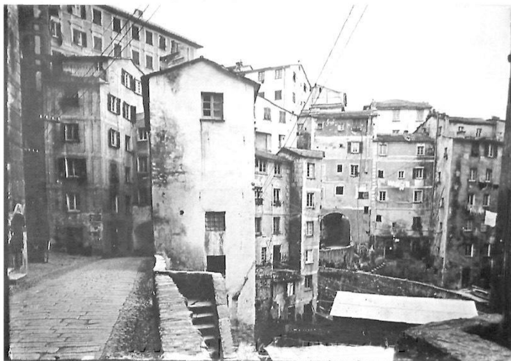
Prima dei lavori dello scalo di costruzione
