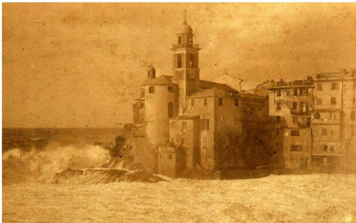
Prima dei lavori del rivo Giorgio
