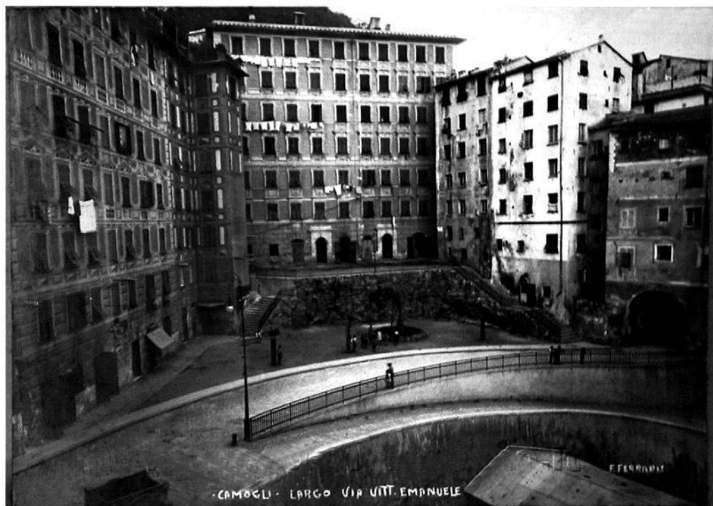
Dopo i lavori dello scalo di costruzione
